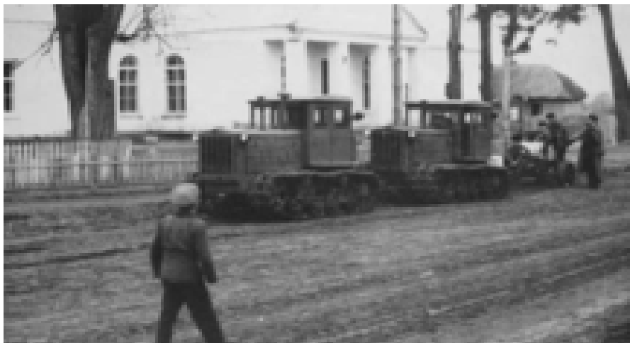
Прокладання телефонного кабеля біля нового сільського клубу в центрі села.
