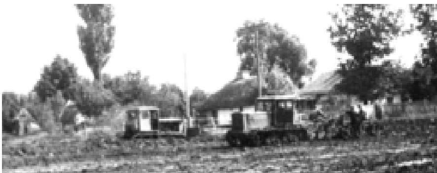
С. Підставки, Новоселівка. Будівництво дороги. (Фото автора).
