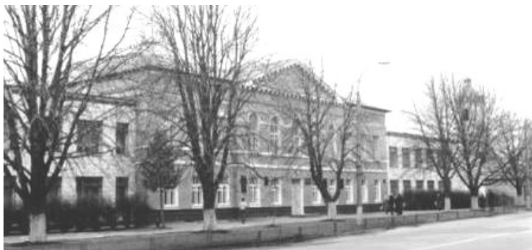
Так виглядала школа після добудови і капітального ремонту.
